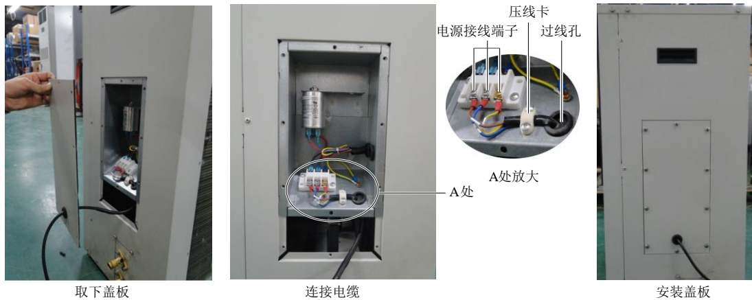
图3-3 标准型室外机设备的电源接线示意图
